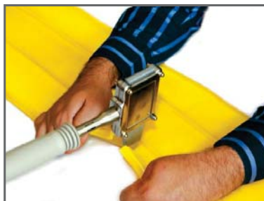
نحوه جوش با دستگاه جوش تبری
